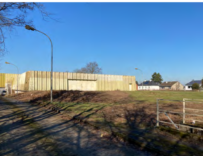
Altes bestehendes Pumpwerk Martinusstraße © StEB Köln
