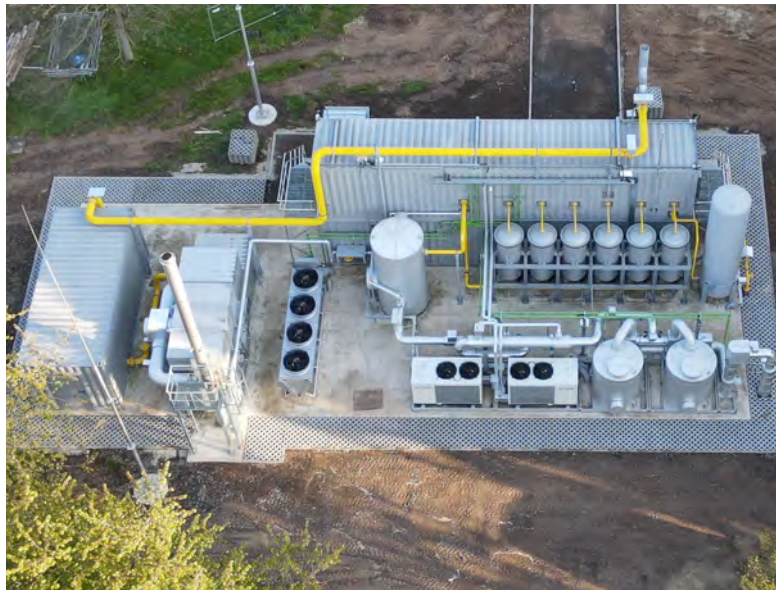
Biogasaufbereitungsanlage in der Bauphase / © StEB Köln, Marvin Moritz
