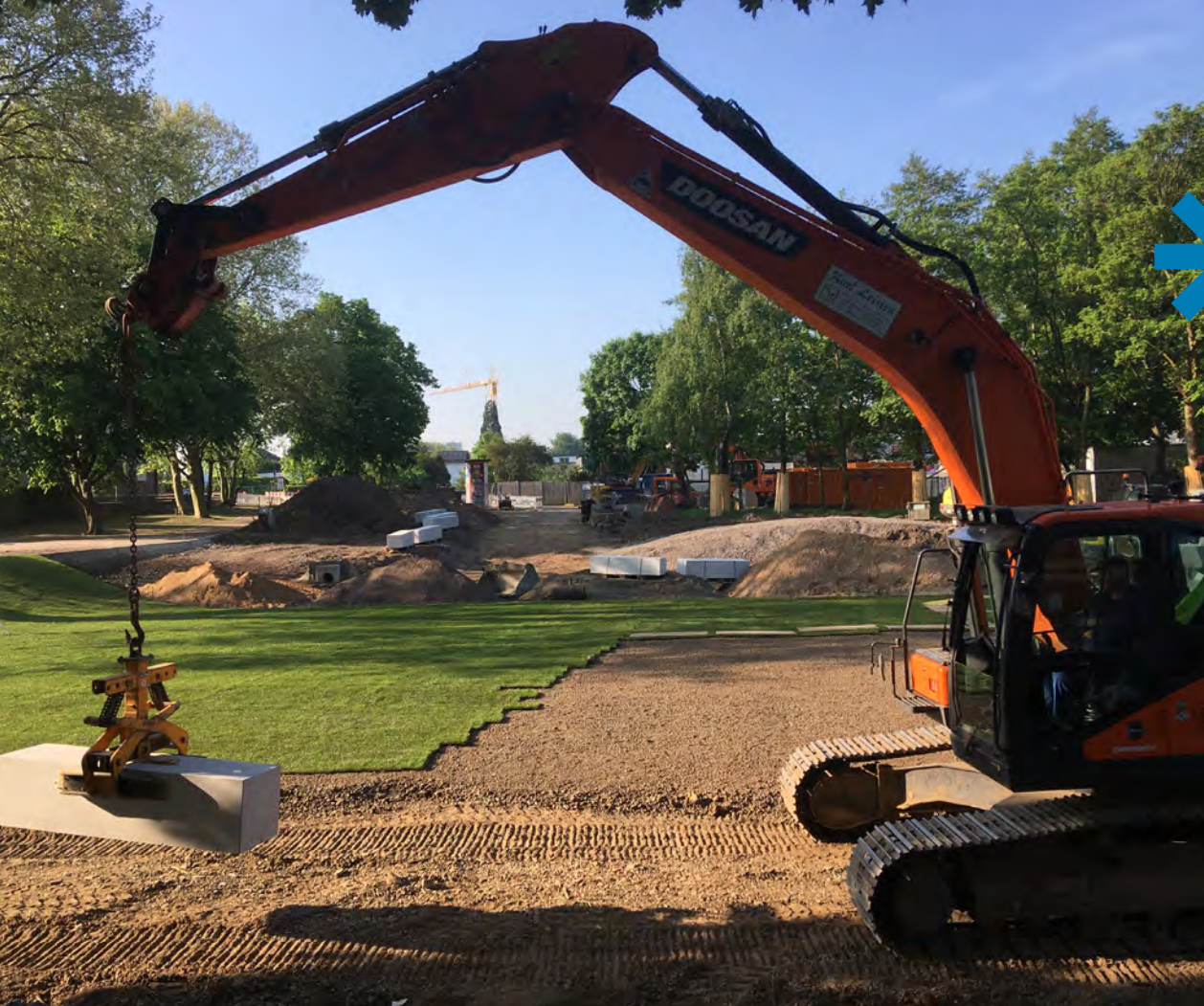
Bauarbeiten am Eiler Schützenplatz / © StEB Köln
