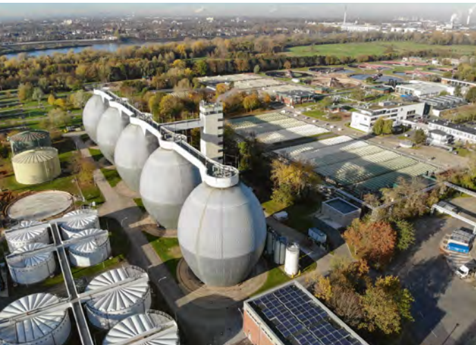
Klärwerk Stammheim © StEB Köln, Sabine Grothues
