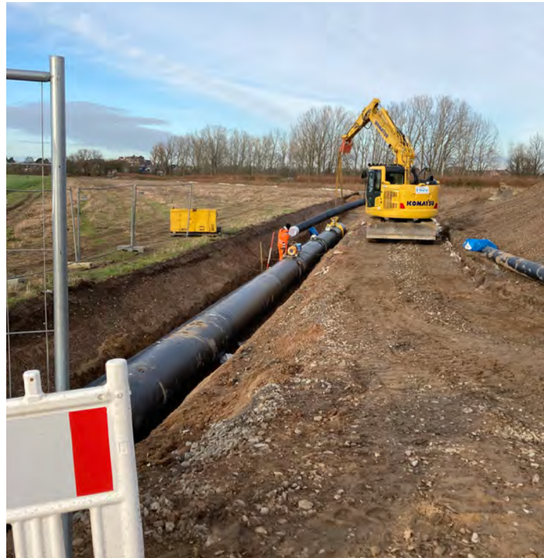
Leitungsverlegung für das Bauprovisorium / © StEB Köln
