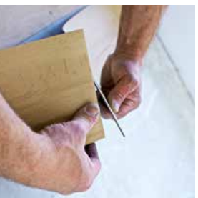
1. Verlegung eines Designbodens im Klebstoffbett
