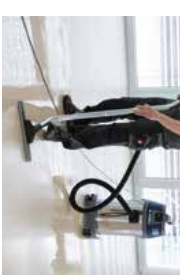
2. Absaugen der Schmutzfrötte und Neutralisieren
